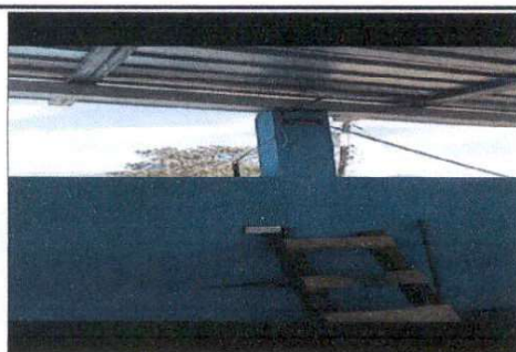
Foto 5: Instalacion de red de electricidad
