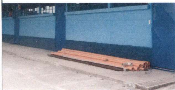
Foto 13: Reparacion de bajada de agua pluvial a tubo PVC
