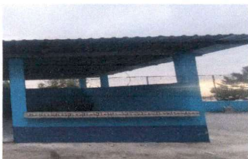
Foto 7: Sustitución de Estructura de metal por ventana.
