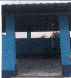
Foto 1: Sustrucción de puerta de metal
