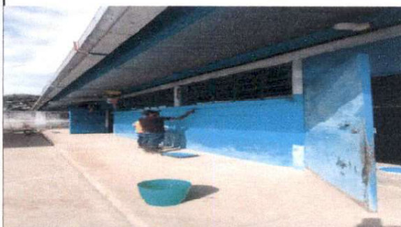
Foto 10: Pintura en muros interiores y exteriores.
