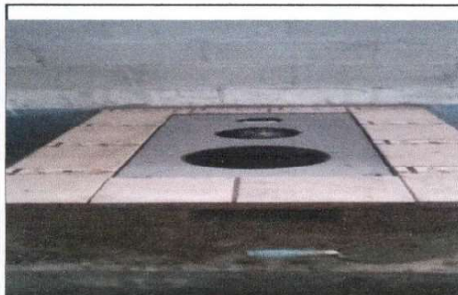
Foto 3: sustitucion de polleton por estufa rural
