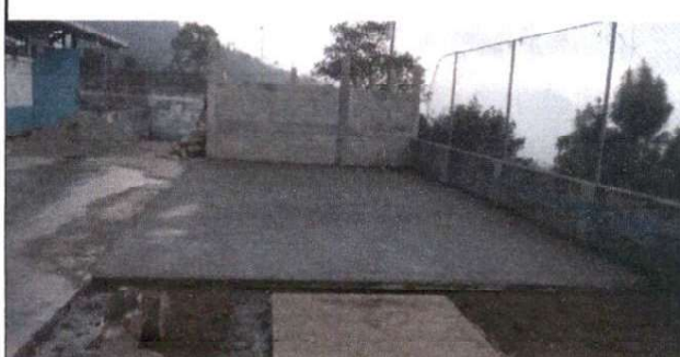
Foto 8: Colocación de torta de cemento.
