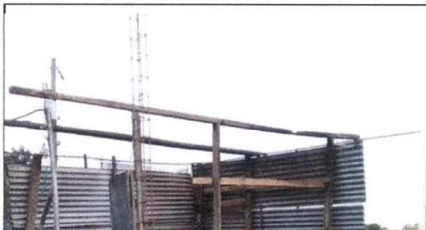
Foto 4: sustitucion de techo por lamina troquelada aluzinc
